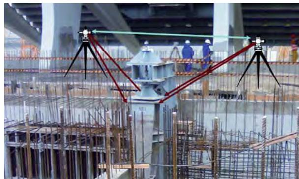
Рис. 7. Визначення положення закладної ЗД-1 методом вільної станції з контролем
