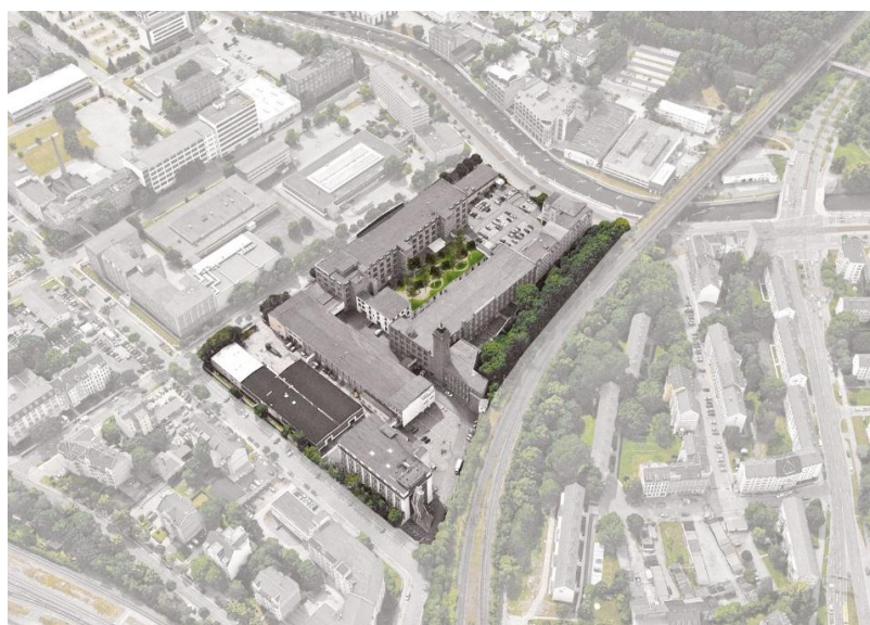
Рис.1. Реконструкція фабричного кварталу Wirkbau Chemnitz з даховим садом як публічним простором. Wirkbau Chemnitz (Meyer-Grohbrügge).
