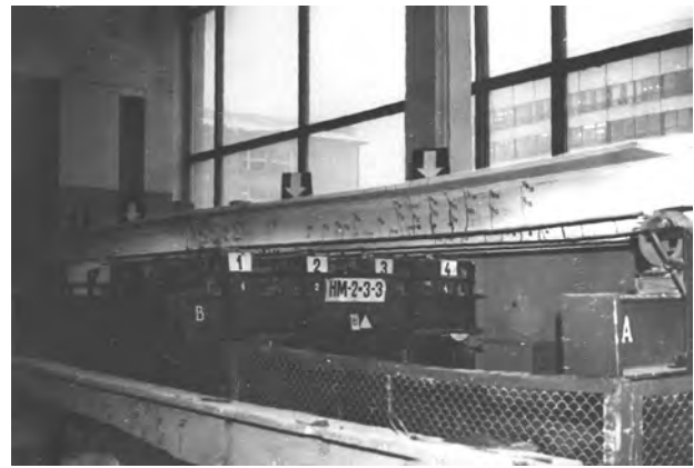
Фото 4. Характер тріщиноутворення в дослідній конструкції нерозрізної прогонової будови без діафрагми
