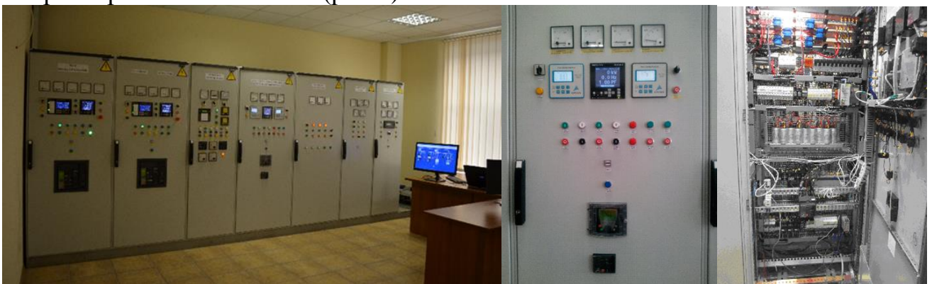
Рис. 3 – 7 із 14 секцій ГРЩ повномасштабного тренажерного комплексу та секція керування асинхронним валогенератором і реактивною потужністю СЕЕС
