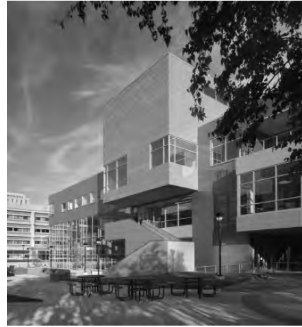
Рис. 1. Архітектурне вирішення зовнішнього вигляду університетського центру в Клівленді, США
